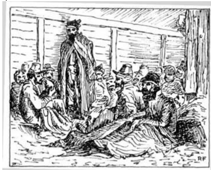
Pavillon de fiévreux à l'hôpital du Dey
